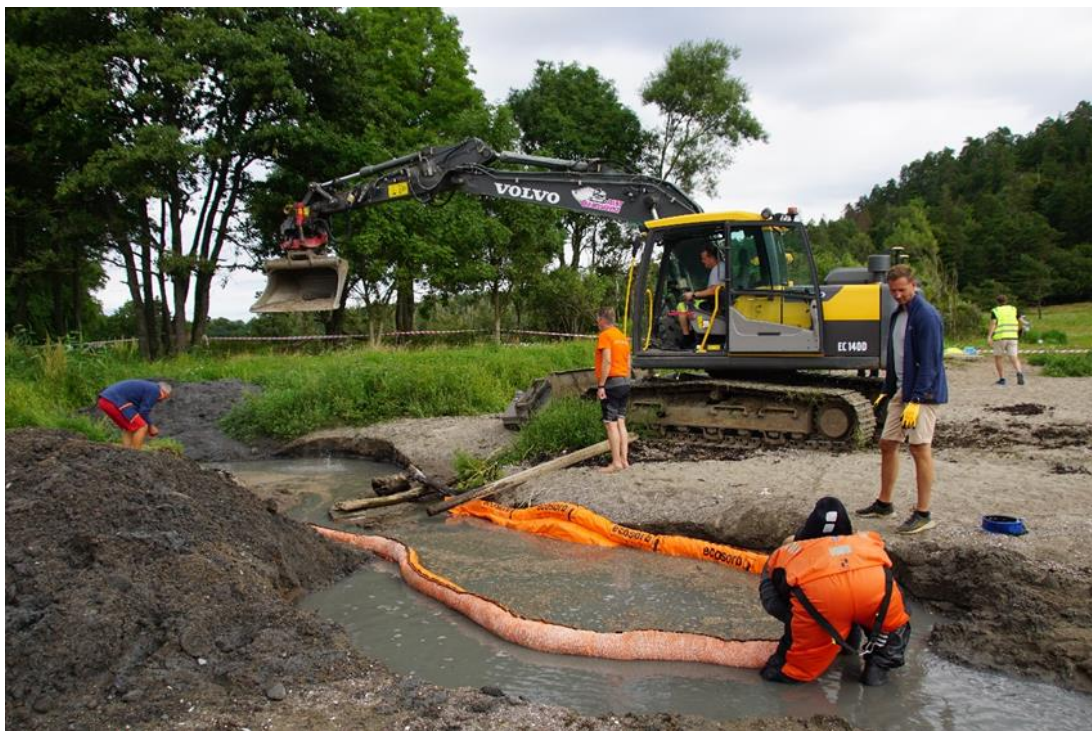
Figura 24: Contención y recuperación mediante arroyo natural. Fuente: ANC
